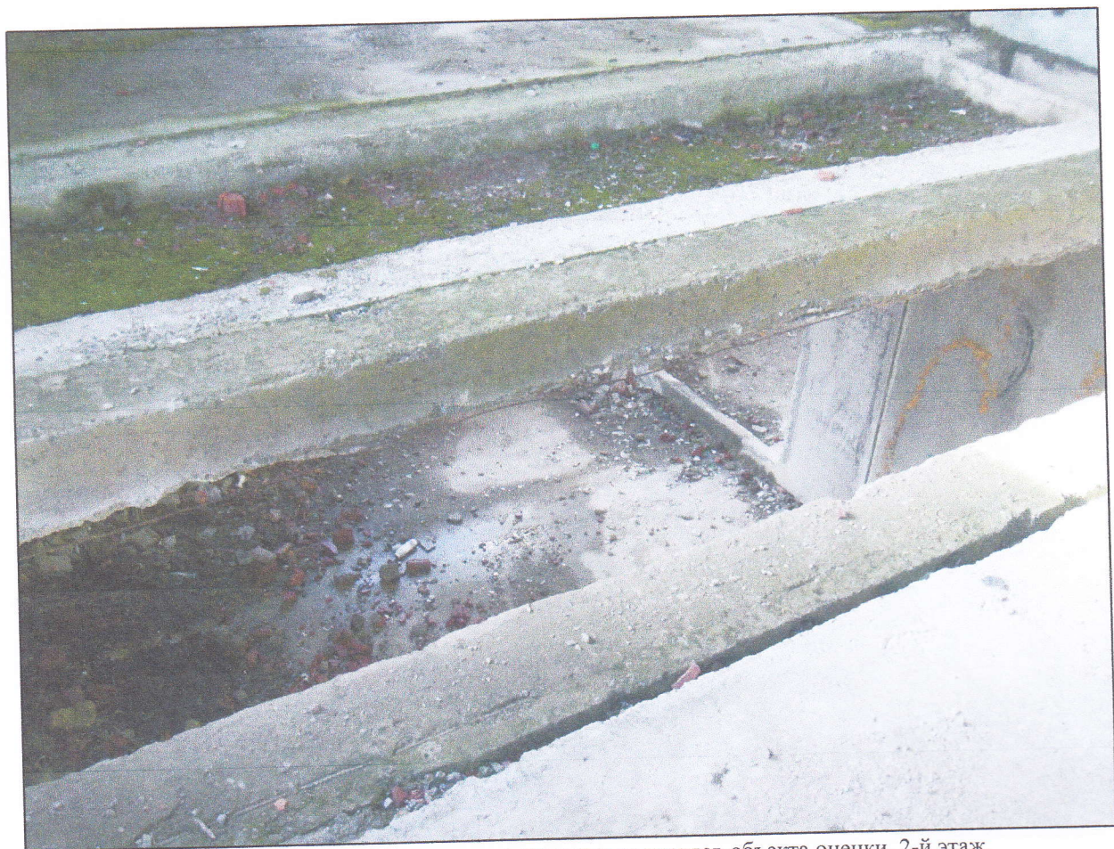
Фото 14. Вид на состояние конструктивных элементов объекта оценки. 2-й этаж.
