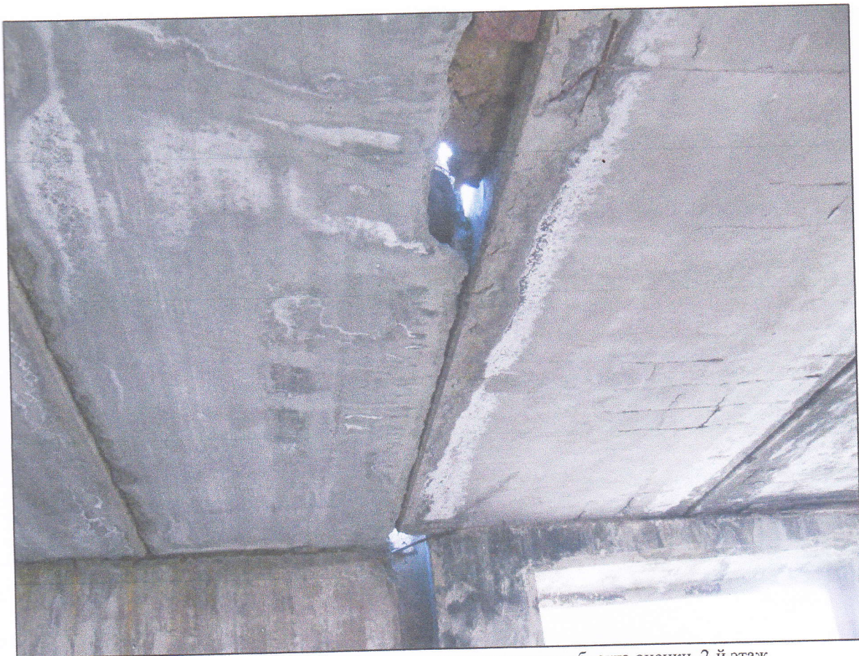
Фото 13. Вид на состояние конструктивных элементов объекта оценки. 2-й этаж.
