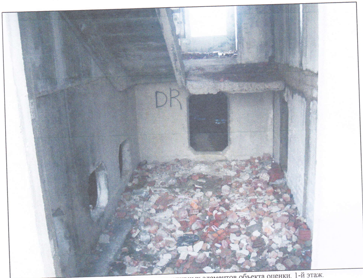
Фото 5. Вид на состояние конструктивных элементов объекта оценки. 1-й этаж.
