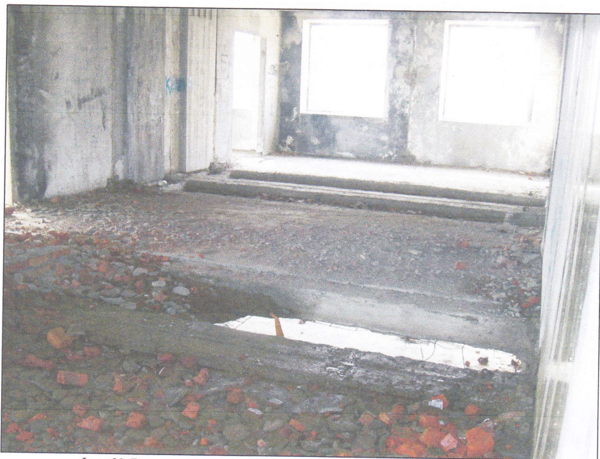
Фото 20. Вид на состояние конструктивных элементов объекта оценки. 2-й этаж.
