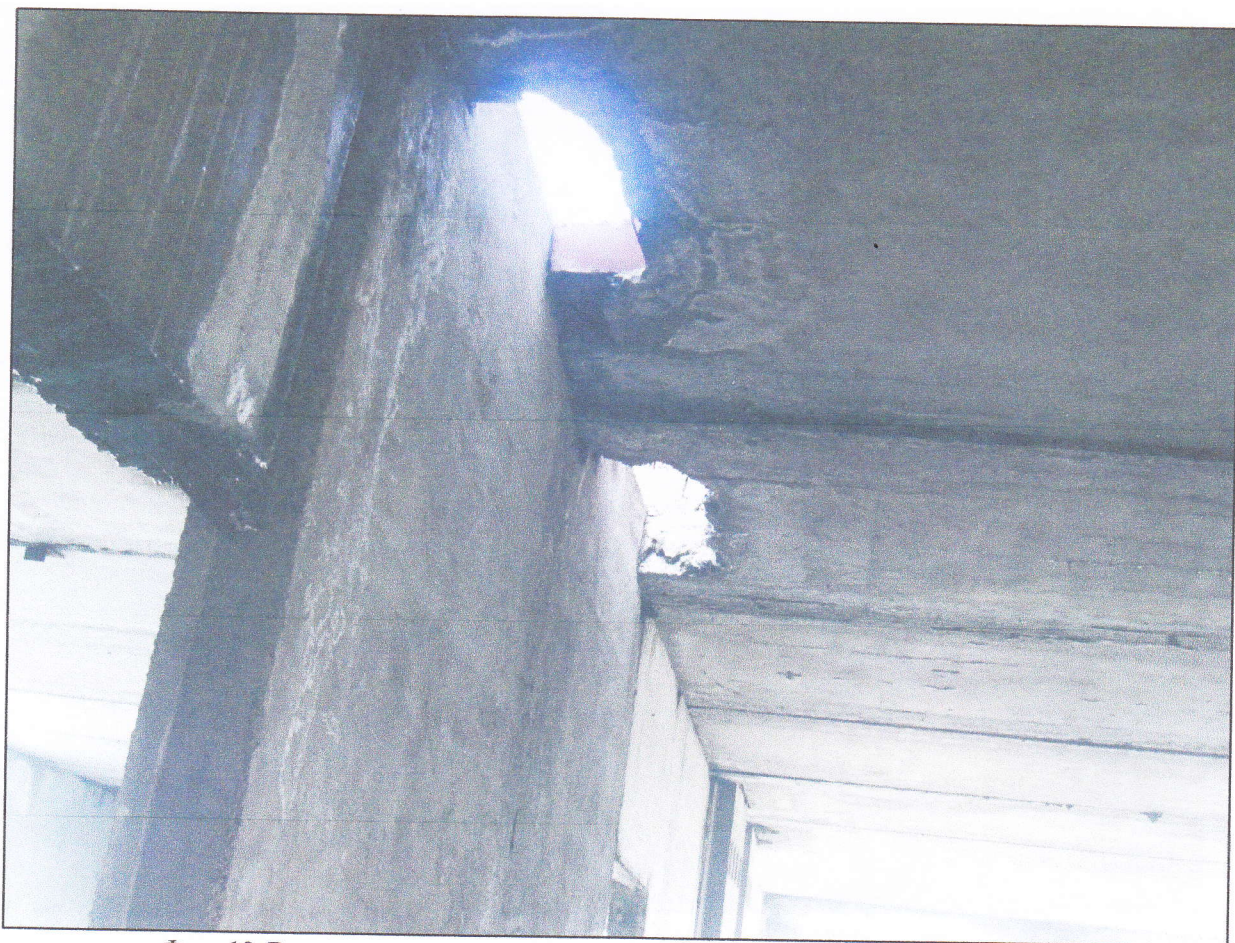
Фото 19. Вид на состояние конструктивных элементов объекта оценки. 2-й этаж.
