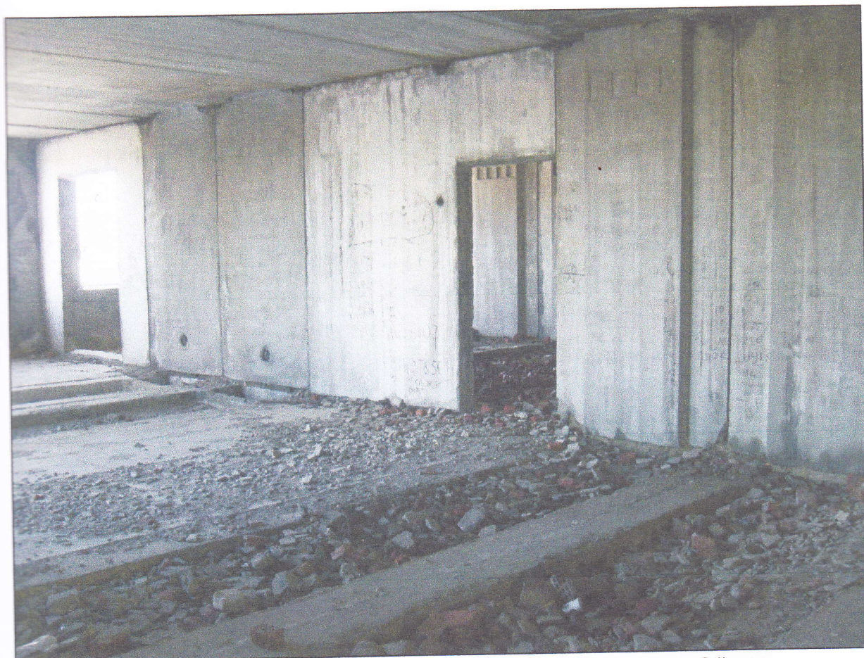
Фото 9. Вид на состояние конструктивных элементов объекта оценки. 2-й этаж.
