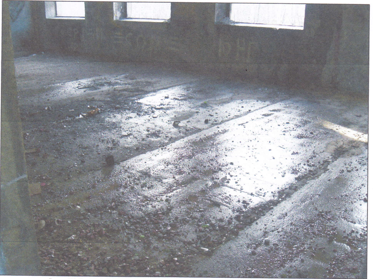
Фото 17. Вид на состояние конструктивных элементов объекта оценки. 2-й этаж.
