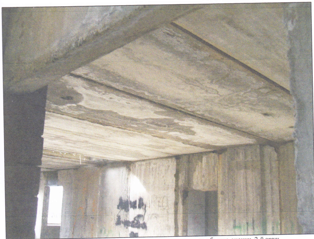
Фото 10. Вид на состояние конструктивных элементов объекта оценки. 2-й этаж.
