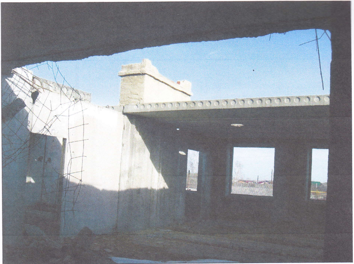
Фото 21. Вид на состояние конструктивных элементов объекта оценки. 2-й этаж.
