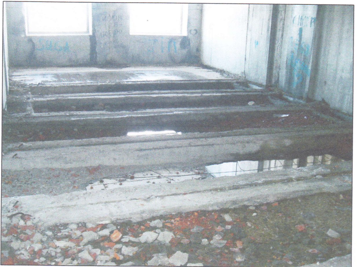
Фото 18. Вид на состояние конструктивных элементов объекта оценки. 2-й этаж.
