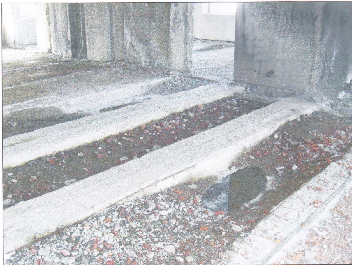
Фото 11. Вид на состояние конструктивных элементов объекта оценки. 2-й этаж.
