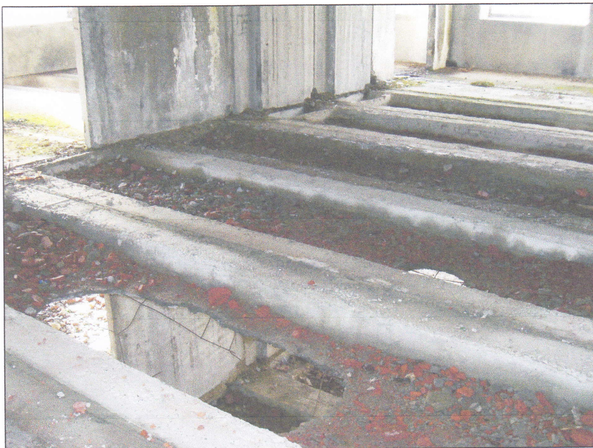
Фото 12. Вид на состояние конструктивных элементов объекта оценки. 2-й этаж.
