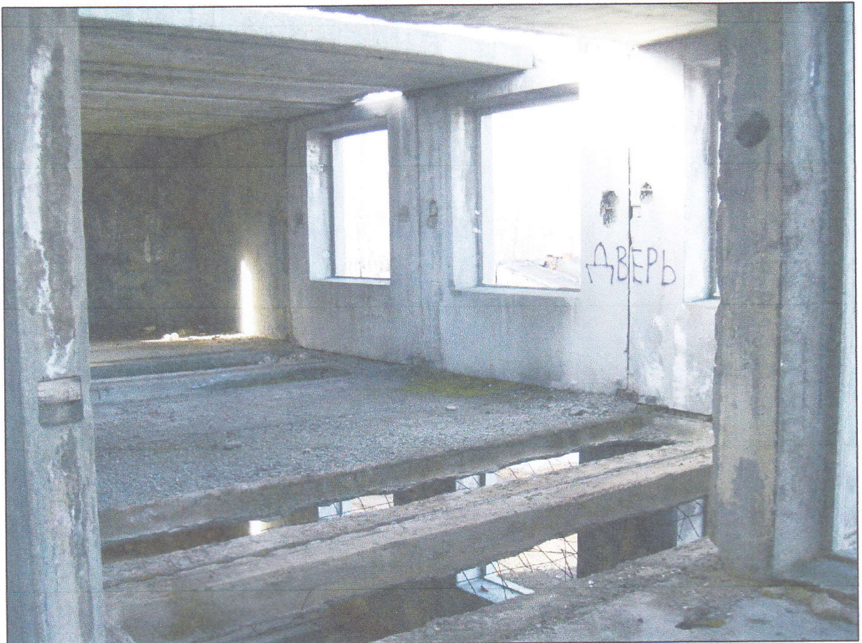
Фото 22. Вид на состояние конструктивных элементов объекта оценки. 2-й этаж.
